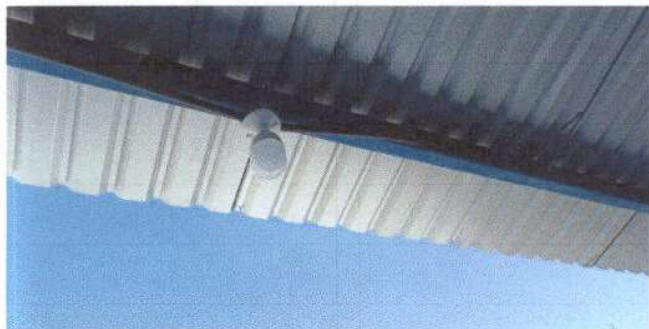
Foto 7: Sustitución de focos ahorradores en módulo de aulas.
