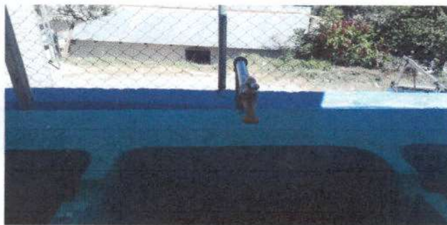
Foto 6: Sustitución de llave de chorro.
