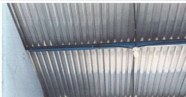
Foto 9: Sustitución de cableado eléctrico sólido en módulo de aulas.
