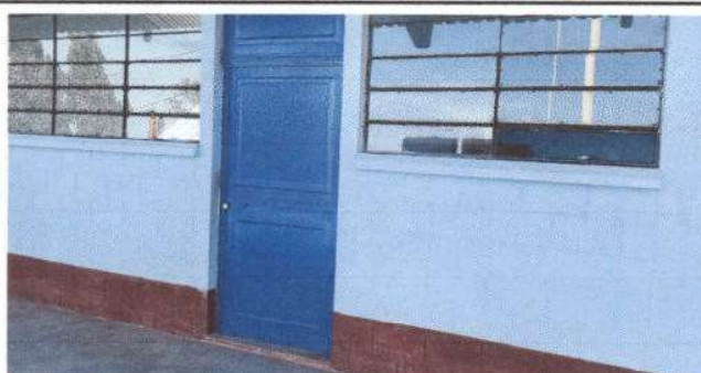
Foto 12: Fabricación e instalación de puertas de metal en módulo de aulas.
