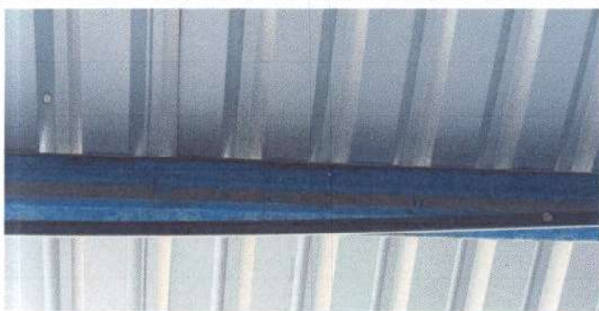
Foto 3: Sustitución de elementos de fijación en módulo de aulas.
