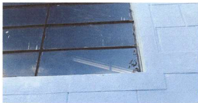
Foto 4: Sustitución de vidrio en módulo de bodega.
