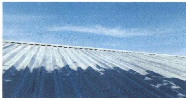
Foto 2: Sustitución de capote de lámina, para lámina troquelada en módulo de aulas.
