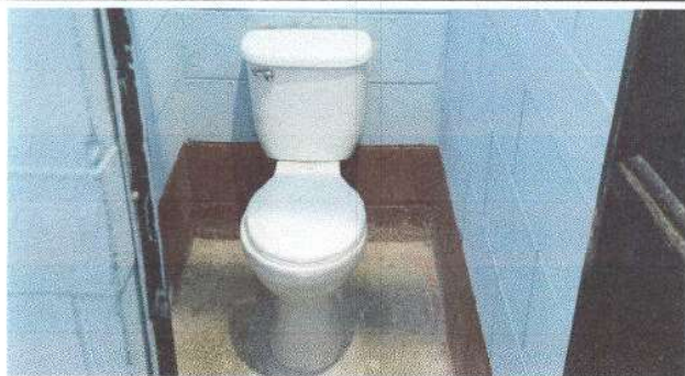
Foto 13: Instalación de inodoro en módulo de baños.
