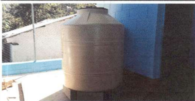
Foto 11: Sustitución de depósito de agua 1100 lt.
