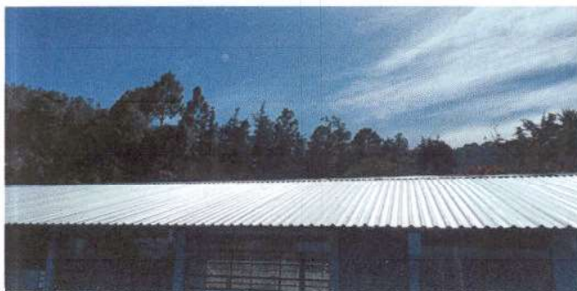
Foto 1: Sustitución de lámina, por lámina troquelada aluzinc calibre 26 en módulo de aulas.
