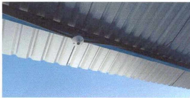
Foto 8: Sustitución de plafoneras en módulo de aulas.
