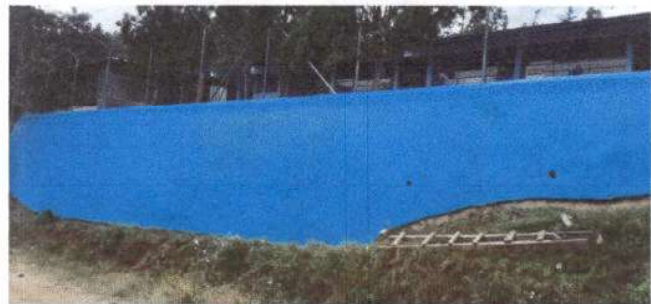
Foto 5: Pintura en muros exteriores.
