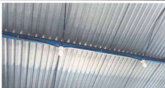
Foto 10: Sustitución de ducto eléctrico + accesorios en módulo de aulas
